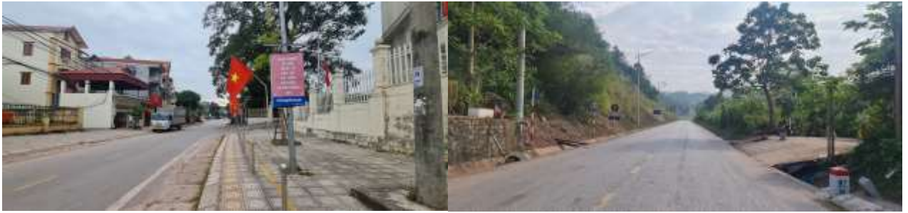
Hệ thống thoát nước mưa
