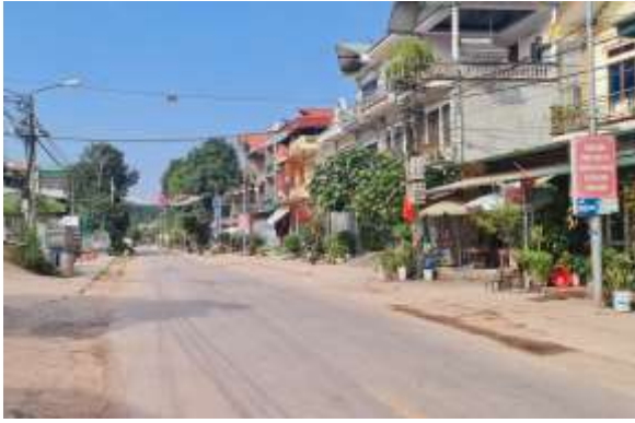
Quốc lộ 4 đoạn tuyến cũ qua đô thị
