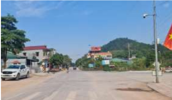
Điểm giao cắt đường tránh QL4 và QL4 tuyến cũ qua đô thị
